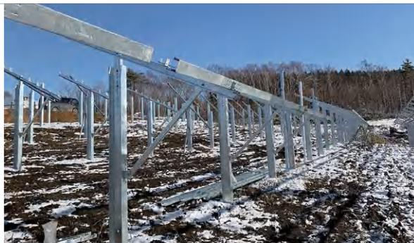
华鼎农光互补安装系统根据组件排布方式、作物所需日照量及农机机械尺寸等设计系统结构,将太阳能发电、现代农业种植、养殖、高效农业设施有机结合,形成高效生态农业模式。
